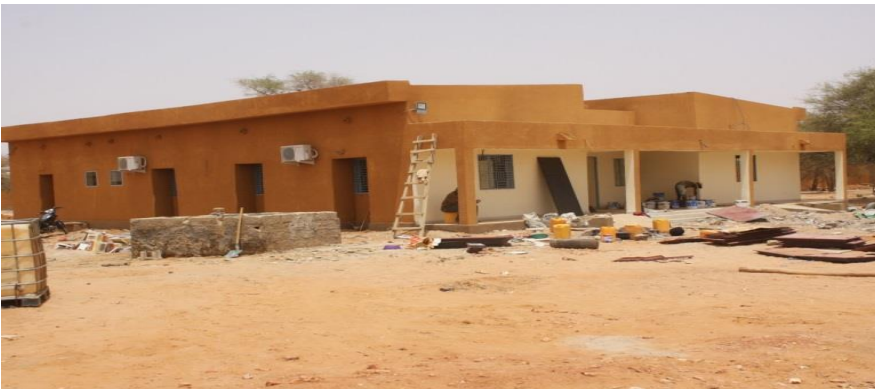
Commissariat de police de Seytenga en construction
