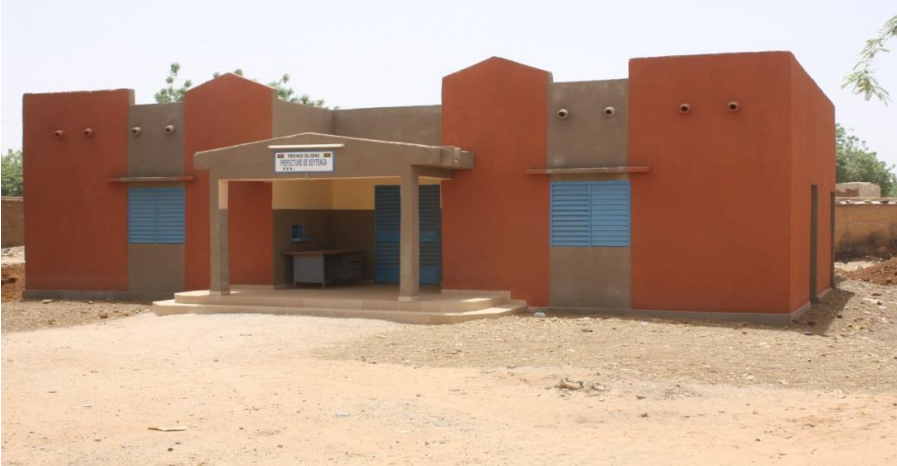
Construction de la préfecture de Seytenga
