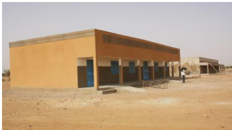
Ecole primaire de Woulmassoutou : construction d'un nouveau bâtiment et réhabilitation de l'ancien
